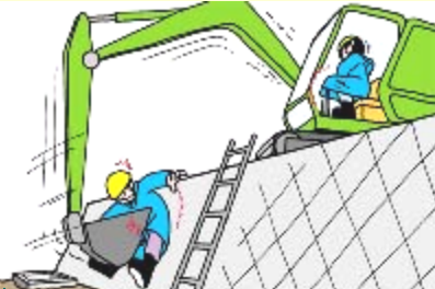
ドラゴパシベルのバケットと築壁との間に挟まれる
